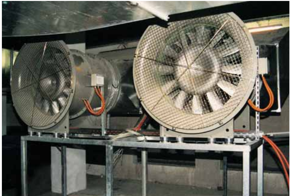
Axial smoke exhaust fan BVAXN 12/56/900 for 300°C - 120 Min. casing insulated (Alsenblöcke, Berlin)
