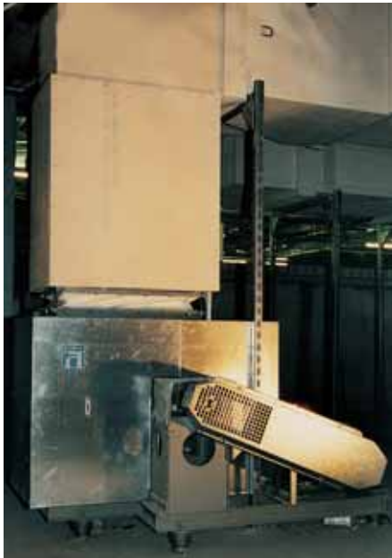
Centrifugal smoke exhaust fan BV-REH 560 for 400°C - 120 Min. casing insulated (Alsenblöcke, Berlin)
