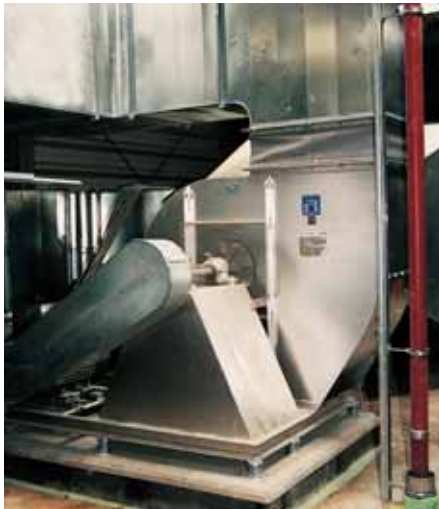
Centrifugal smoke exhaust fan BVRA 710 for 620°C - 90 Min. (Dorotheen-Blöcke, Berlin)
